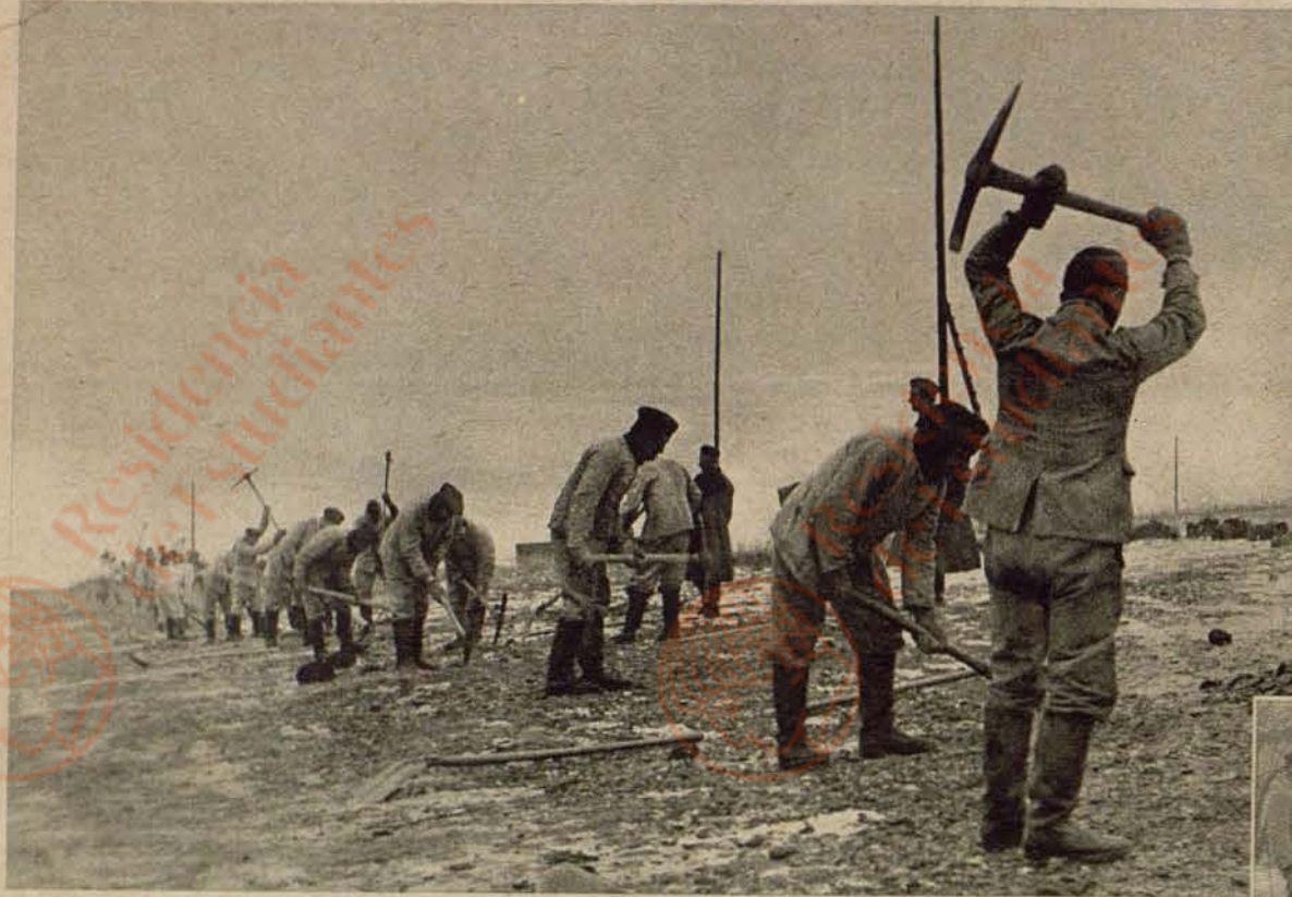
Die Fluchlinie für den neuen Graben ist abgesteckt. Jetzt wird sie mit dem Pickel angekratzt. Der glasharte Boden leistet energischen Widerstand, bald aber ist die Linie genau zu erkennen, an der wenig später ein Graben entlang laufen wird
