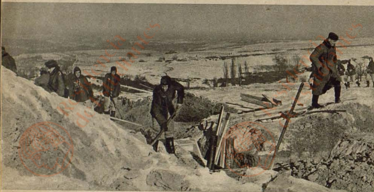
Die Baukompanie an der Arbeit. In bestimmten Abständen werden Unterstände und Stollen in die Erde getrieben. In diesen harten Wintermonaten sollen sie vor allem als Schutz gegen die Unbilden der Witterung dienen
