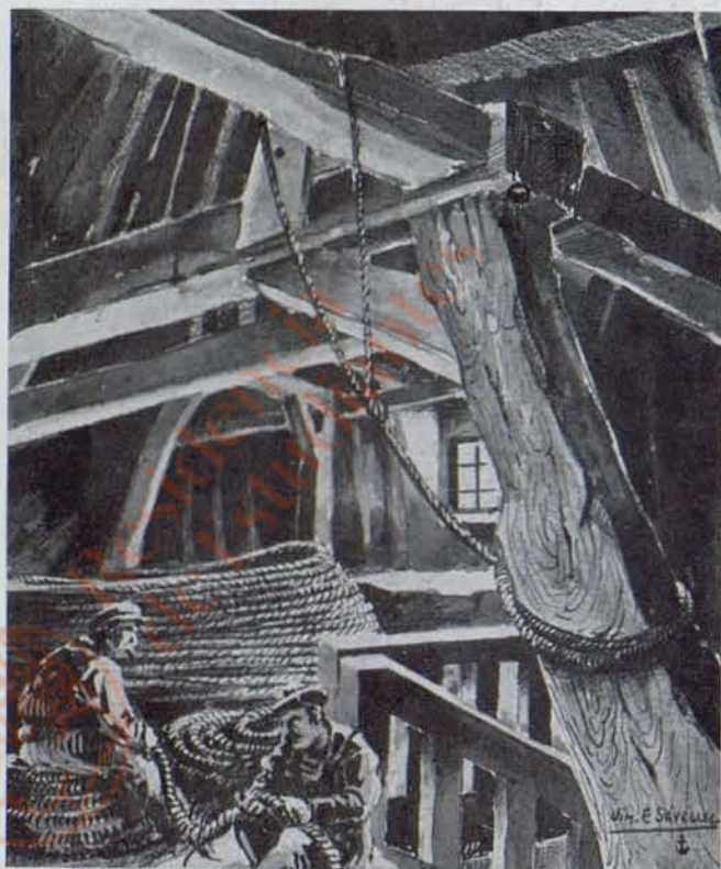
Sur cette charpente de chêne massif qui date de Colbert, deux matelots font une épissure d'aussière (ligature sur un gros câble).
