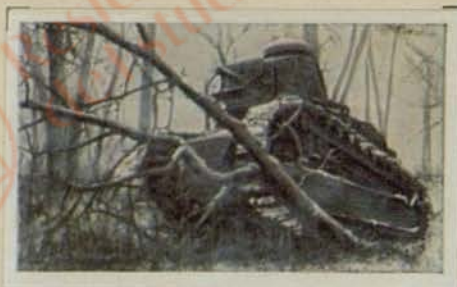
Amerikanischer 3-Mann-Tank. Bewaffnung 37 mm Kanone, 1 MG. Munition 80 Schuß 37 mm und 3000 Schuß MG.
