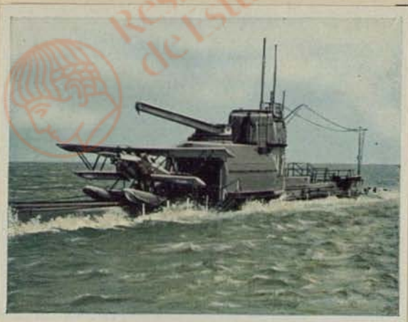
Englisches U-Boot „M 2“ mit Bordflugzeug und Katapultanlage. Besatzung 60 Mann. Wasserverdrängung 1950 t. Bestückung 1 × 7,6 cm Kanone und 4 Torpedoausstößrohre
