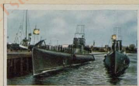
Italienische U-Boote der Klasse Balilla. Besatzung 80 Mann. Wasserverdrängung 1874 t. Bestückung 1 × 10 cm Kanone, 6 Torpedoausstößrohre
