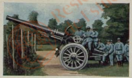
Französisches Langrohrgeschütz. Kaliber 15,5 cm, Gewicht etwa 11 200 kg. Schußweite 20 km
