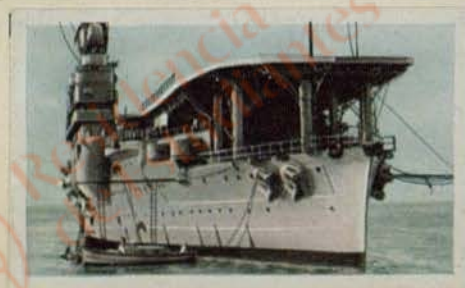
Französisches Flugzeugmutter Schiff „Béarn“. Besatzung 750 Mann. Wasserverdrängung 22 146 t. Fassungsvermögen 40 Flugzeuge
