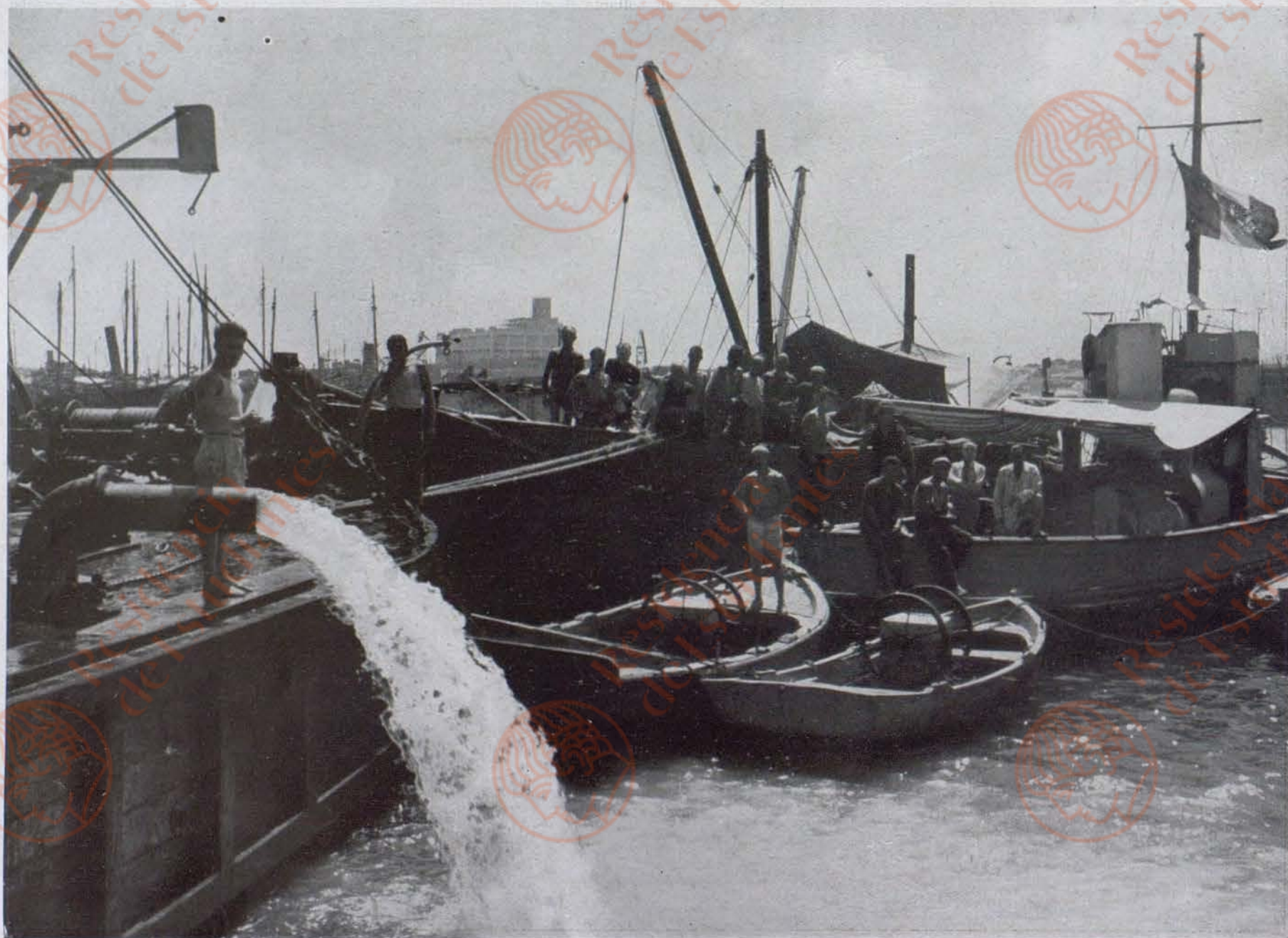
Tonnellate d'acqua vengono aspirate dall'interno della nave affondata della quale sono state con un duro e attento lavoro tamponate le falle prodotte dalle bombe o dai siluri, in modo da renderla impermeabile, e da consentirle con l'alleggerimento, di ritornare a galla. L'opera infaticata dei palombari italiani è così coronata dal più completo successo.
