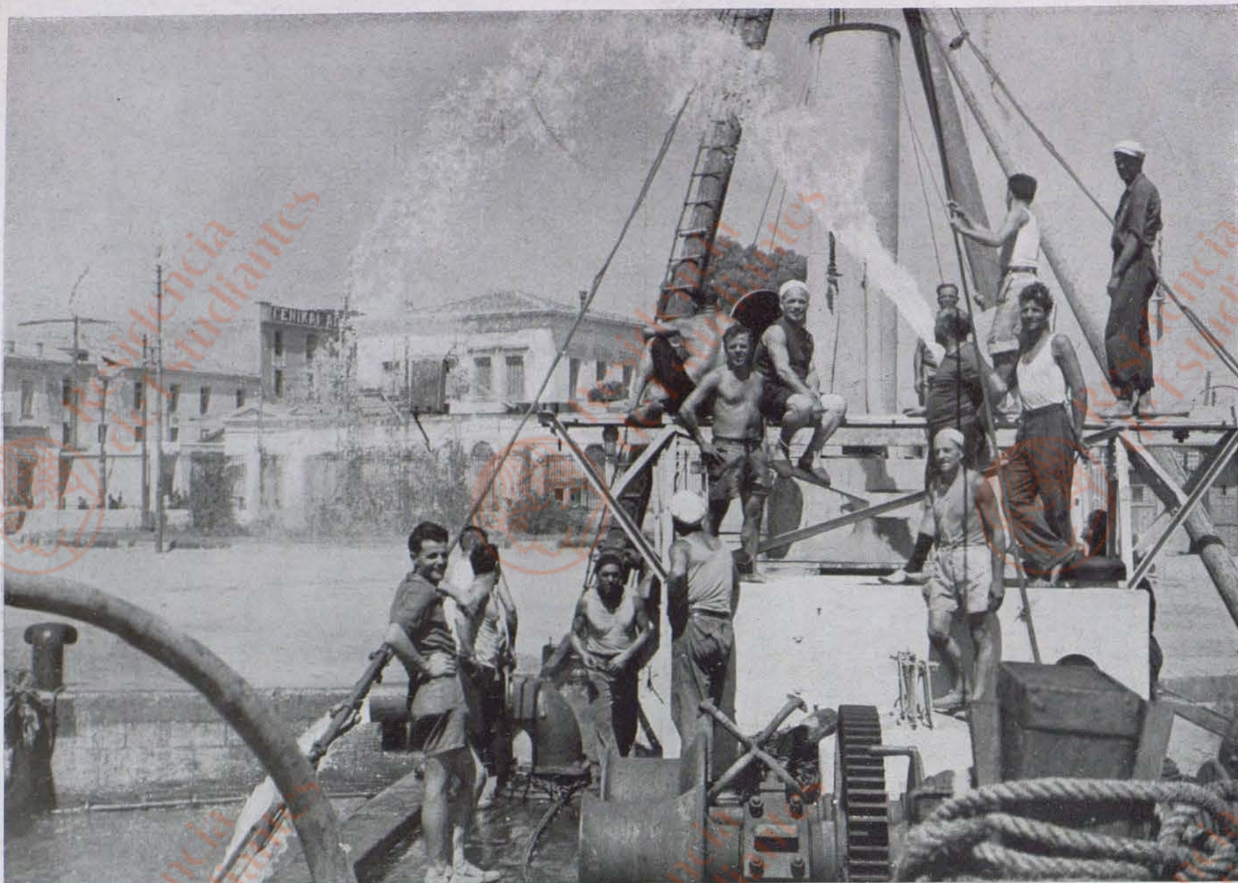
Tonnellate d'acqua vengono aspirate dall'interno della nave affondata della quale sono state con un duro e attento lavoro tamponate le falle prodotte dalle bombe o dai siluri, in modo da renderla impermeabile, e da consentirle con l'alleggerimento, di ritornare a galla. L'opera infaticata dei palombari italiani è così coronata dal più completo successo.
